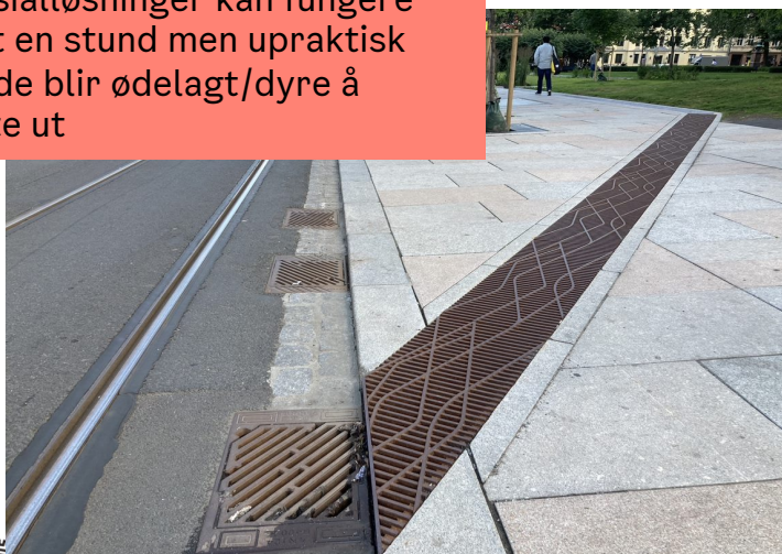
Enkel nedsenk i kantstein. Enkel vei for vannet, enkelt å brøyte og vedlikeholde
