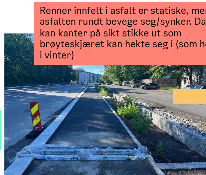
Enkel nedsenk i kantstein. Enkel vei for vannet, enkelt å brøyte og vedlikeholde
